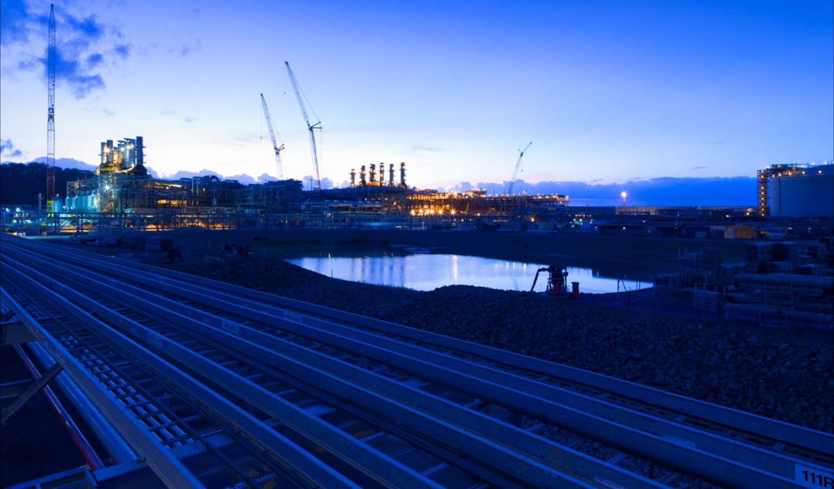
Curtis Island LNG, Queensland
