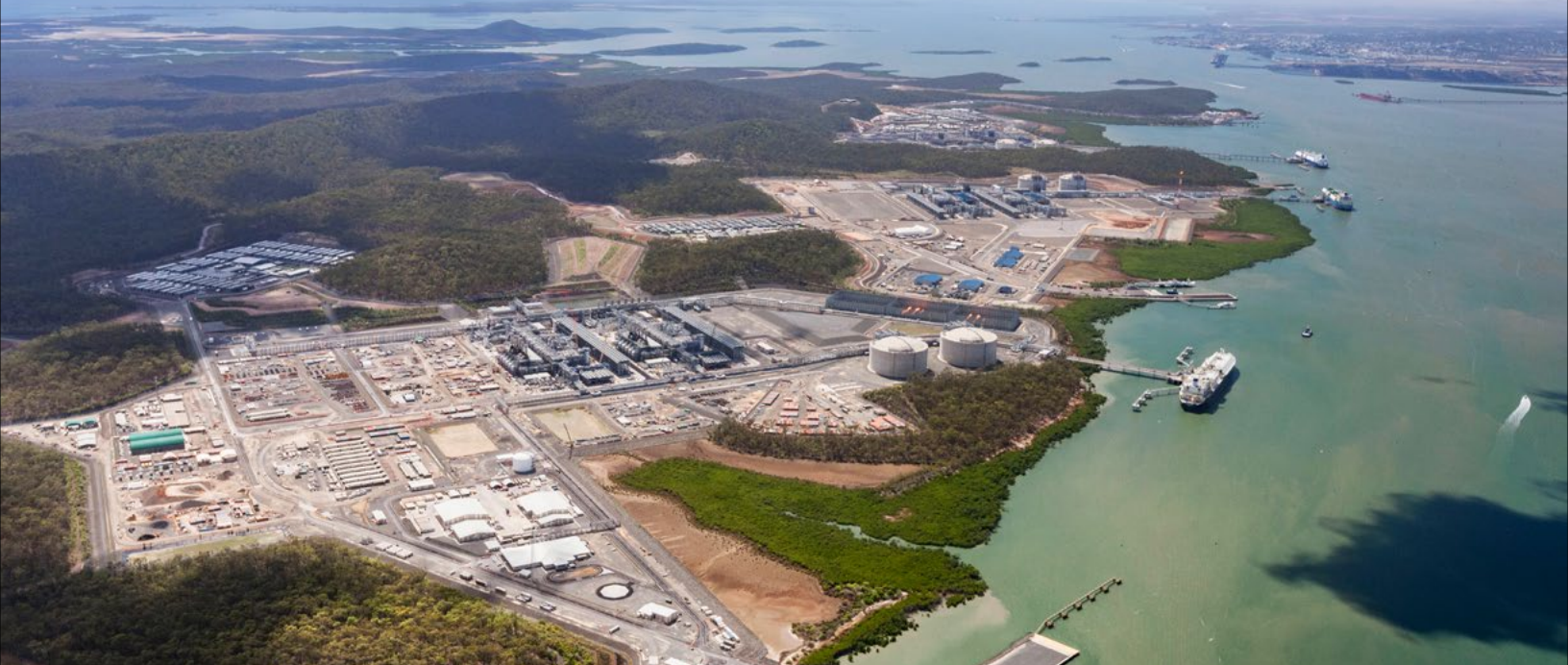
Curtis Island LNG, Queensland
