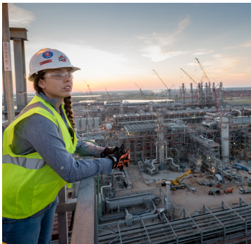
Corpus Christi LNG, USA
